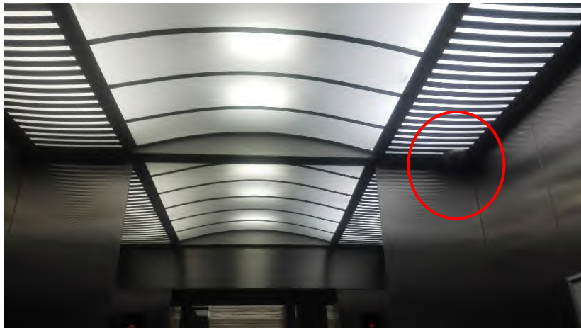
图 13. 电梯轿厢监控安装示例图
