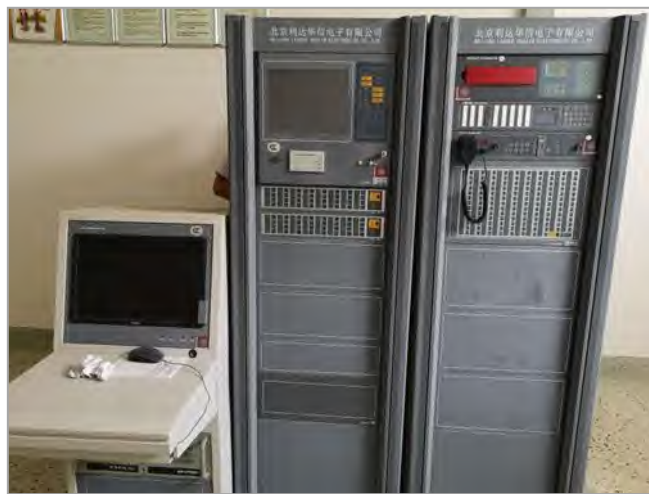
图 99. 故障火灾报警控制器
